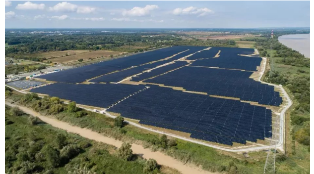
Exemple de parc photovoltaïque
